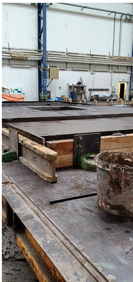
Nehézbeton tároló vibrálás és simítás után
