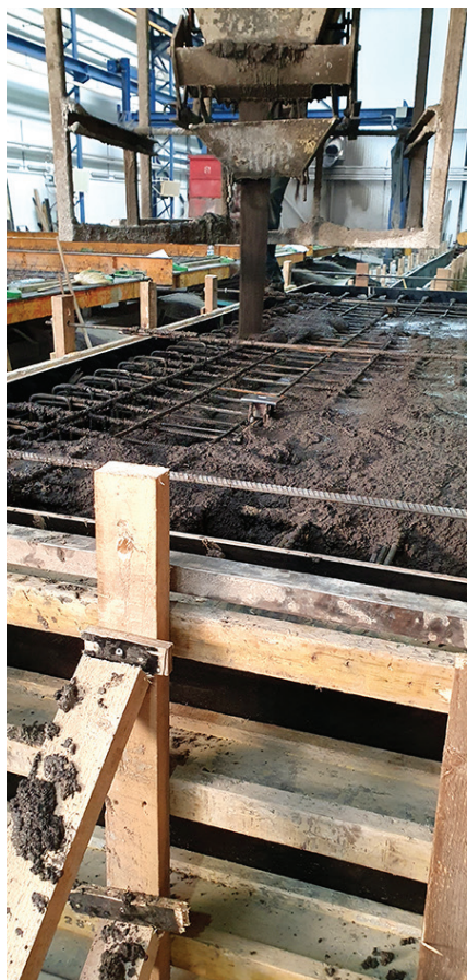
Nehézbeton tároló öntése
