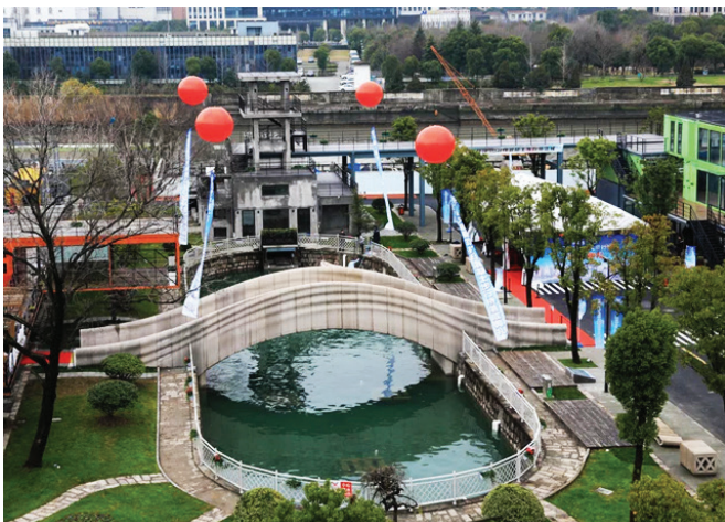
3D-nyomtatott betonhíd, Sanghaj, Kína
