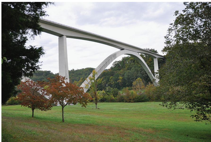
Natchez Trace Parkway híd, Franklin, Tennessee állam, Egyesült Államok
