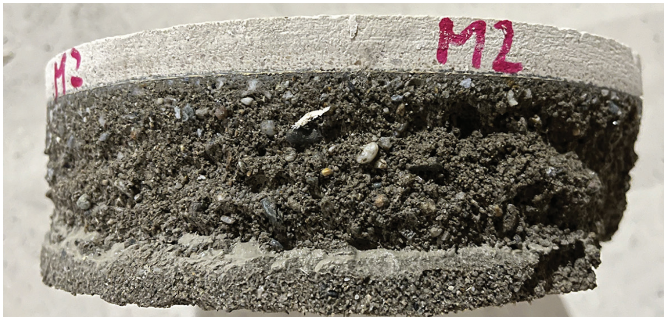
2. kép: Kb. 20 éves, de rossz állapotú esztrichpadozat keresztmetszete, nem alkalmas az új burkolat fogadására.
