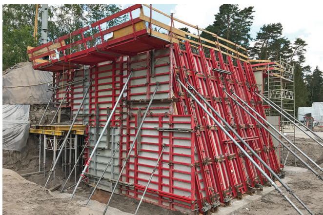
A francia A9 autópálya feletti híd
