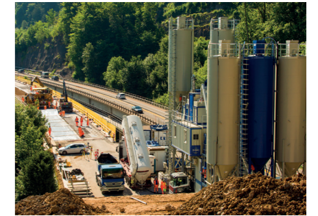
A közelmúltban az A4-es Küsnacht–Brunnen autópálya három hídjánál szálerősített, nagy teljesítményű betont alkalmaztak.
