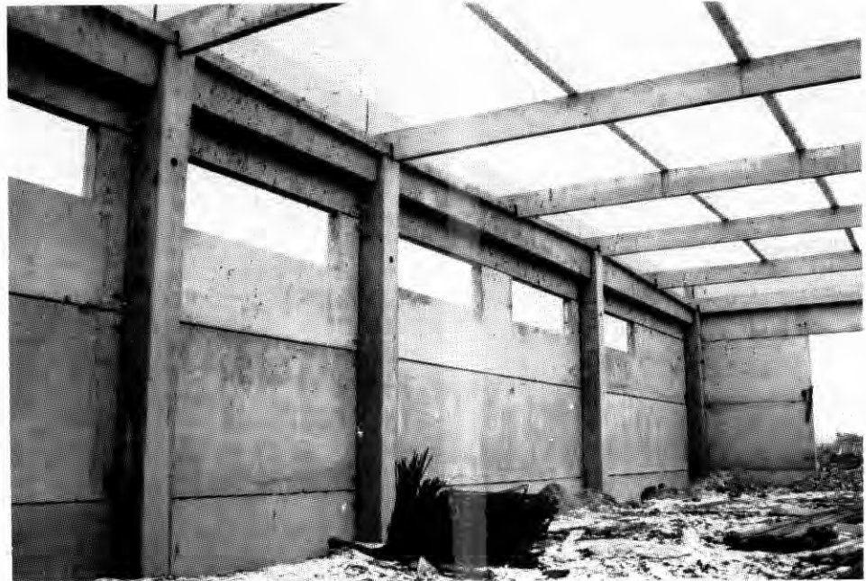
A szerkezet építés közben
