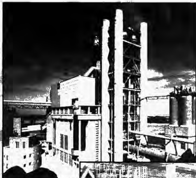
BEUMER nagyteljesítményű elevátorok a nyersliszt szállítására
