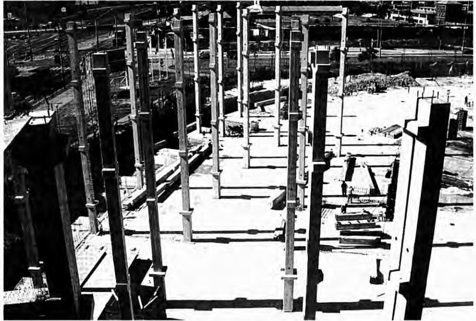
Az építkezés kezdete
