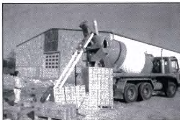
Az acélszál adagolása a mixerkocsi keverődobjába
