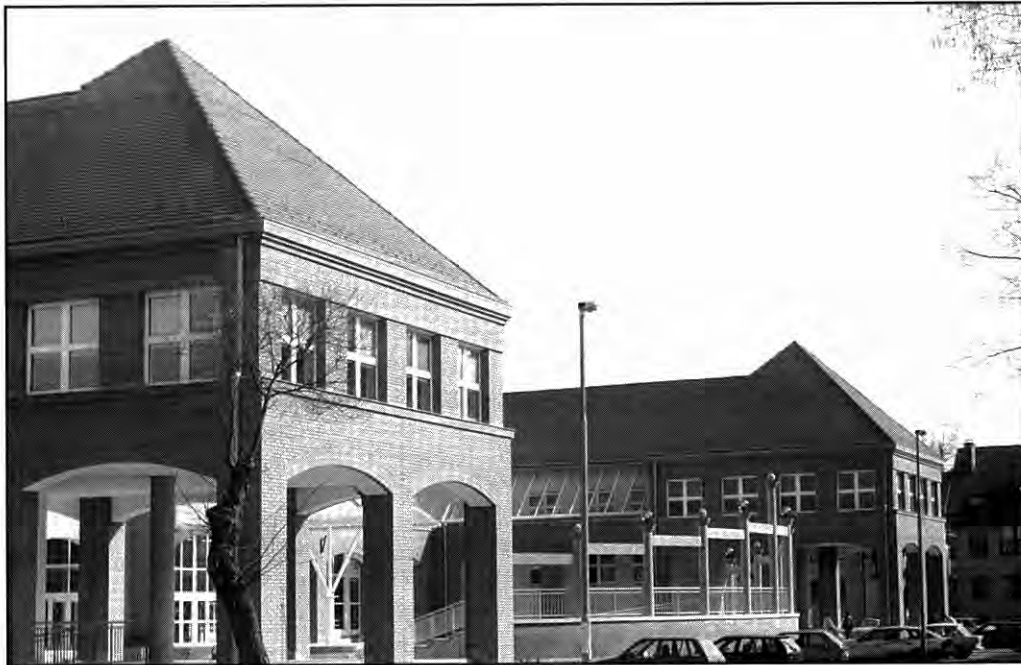
Tóth Árpád Gimnázium épülete - Debrecen
