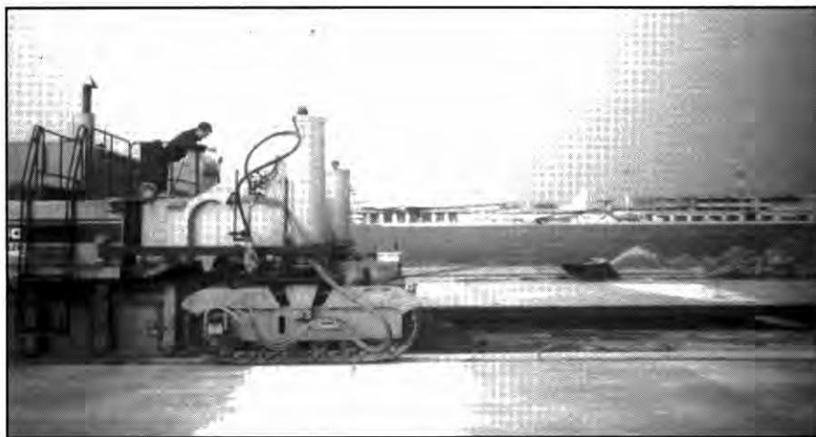
MAPEFLUID X404 adalékszeres alapbeton készítése Velencében, a Marco Polo repülőtéren
