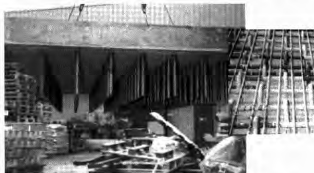
2. ábra A saru talpa a Nelson-szegeccsekkel és a hídpillér vasalása
