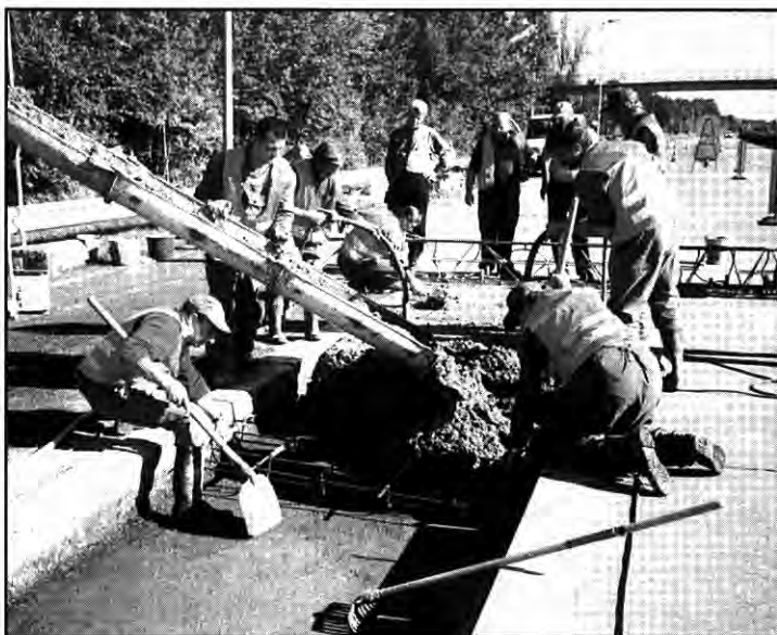
1. kép Az előkészített tábla betonozása
