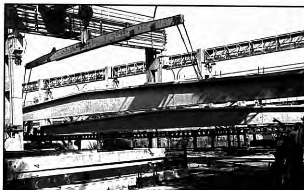
Hídelem rakodása a tárolótéren
