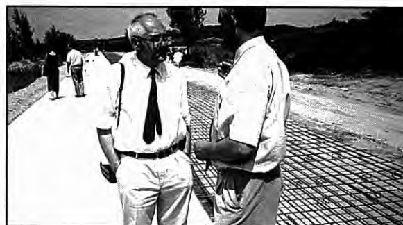
Az elkészült és az épülő útszakasz
