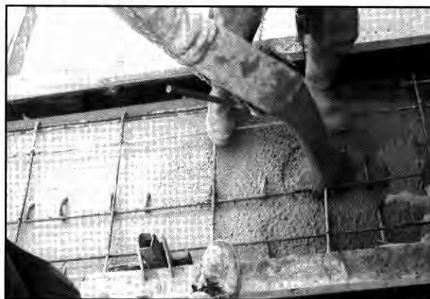
4. ábra Betonozás szivattyúval
