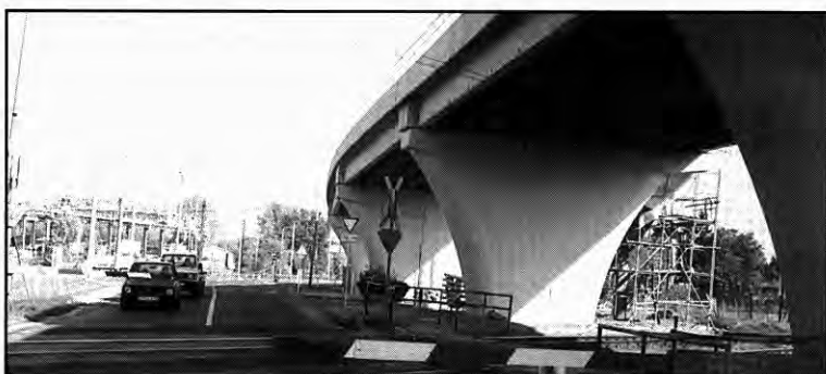
3. ábra Korrózióvédő bevonatok készítése Budapesten, a Jászberényi úti felüljárónál
