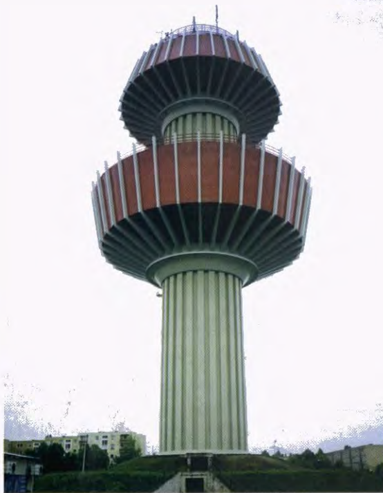
Toronytörzs löttbetonos javítása és korrózióvédő bevonat készítése (Győr – Marcalvárosi Víztorony)
