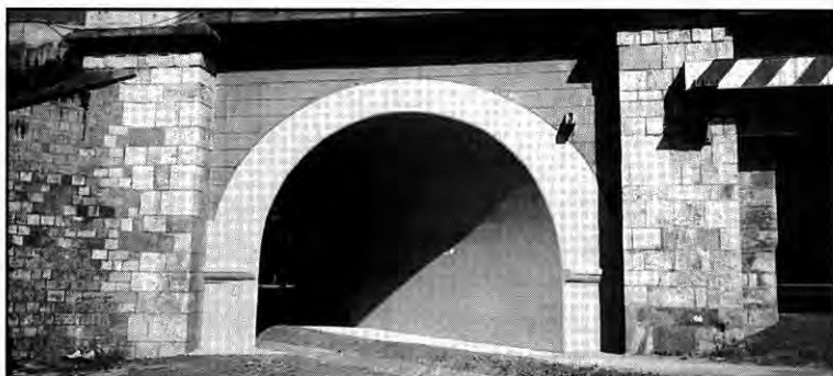
2. ábra Boltozat löttbetonos erősítése Zebegénynél, a váci vasútvonalon
