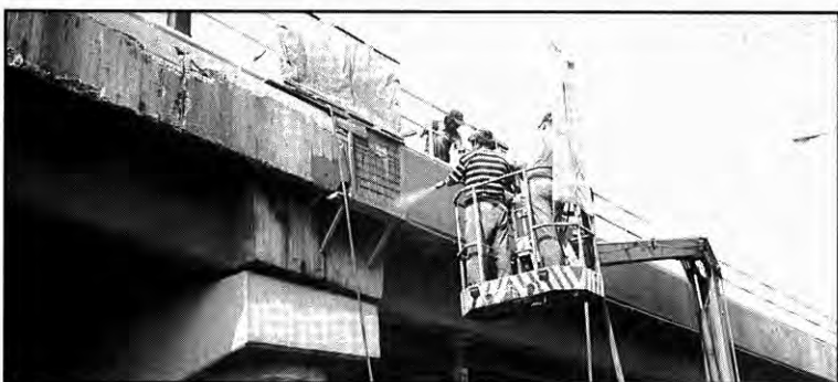
4. ábra Hídszegély löttbetonos erősítése a Jászberényi úti felüljárónál
