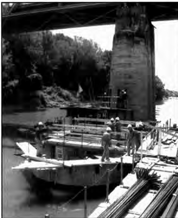
A mederpillér szélesítése Tiszaújnán
