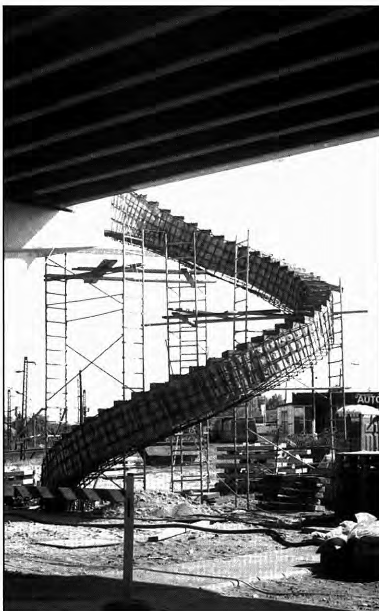
1. ábra Spirál lépcső főtartójának erősítése Budapesten, a Jászberényi úti felüljárónál
