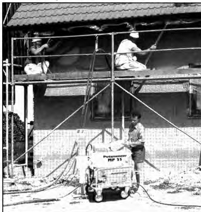
5. ábra A vakolás gépesítése
