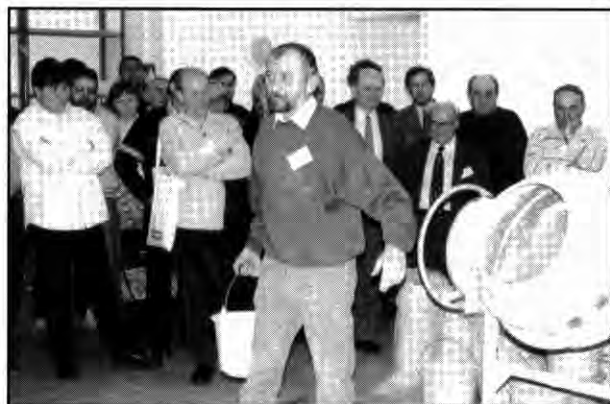
3. ábra A betonkeverés előkészítése
