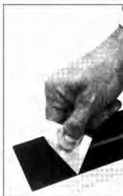
16. ábra A védő- film eltávolítása
