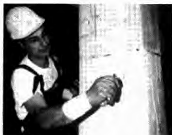
11. ábra Simítás MAPE- WRAP 11-el és MAPEWRAP 12-vel
