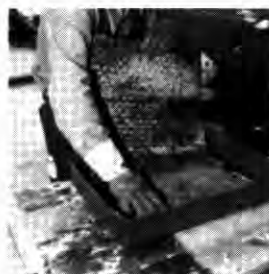
12. ábra MAPE- WRAP C impregnálása kézzel
