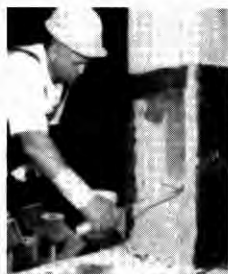
10. ábra MAPEWRAP PRIMER felhordása
