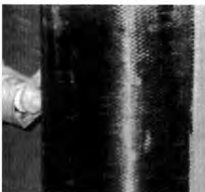
5. ábra Oszlop megerősítése a szénszálás szerkezetmegerősítő rendszerrel
