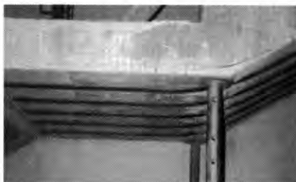
3. ábra Monolit vasbeton lépcső megerősítése
