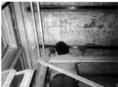
4. ábra Acélgerendás földem megerősítése
