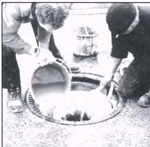
2. ábra: Aknakeret megemelés utáni kitöltése
