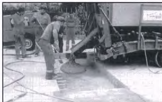
3. ábra: Beton útpálya gyors javítása
