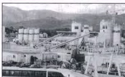
4. ábra A hidépítést kiszolgáló betonüzem és környéke
