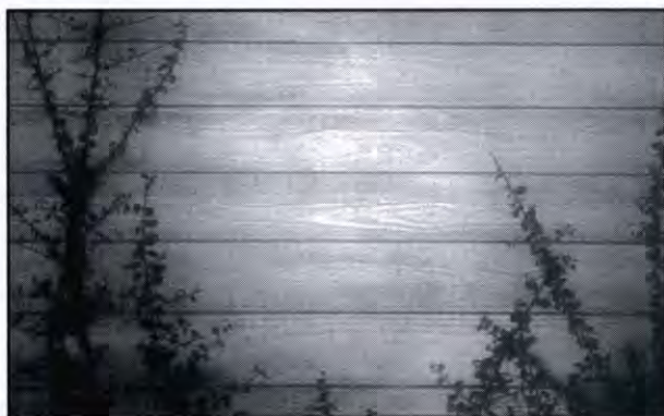
1. ábra Deszkazsaluzatos felületalakítás (Budapest)
