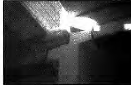
4. ábra Pillérkonzolok eltérő magasságban (Miskolc)
