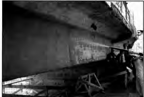
2. ábra Betonlövés egy hídszerkezeten
