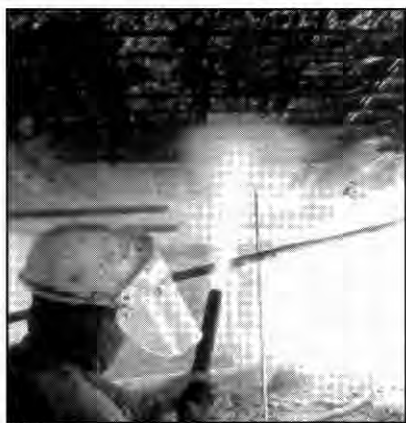
1. ábra Hídszerkezet javítása „száraz” betonlövéssel
