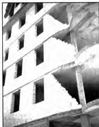
Építkezés pórusbeton falazóelemekkel
