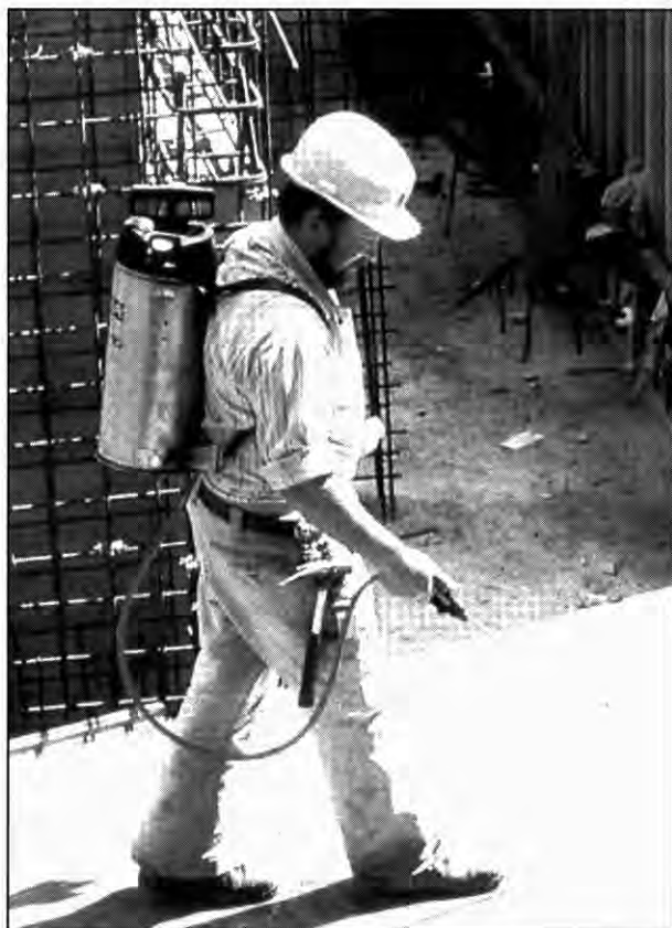
3. ábra Formaleválasztó felhordása a zsaluzatra
