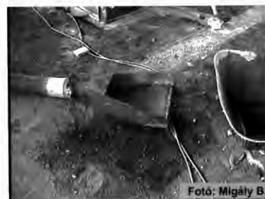
2. ábra A pillérköpeny betonozását könnyítő szerelvény
