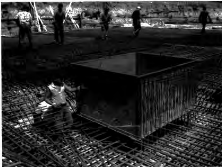
9. ábra Acéllemez szigetelés elhelyezése süllyesztékben
