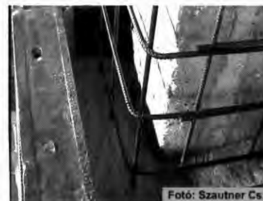
3. ábra A pillérköpeny készítése
